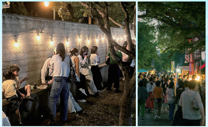
白川夜市は、「緑の区間」が生まれたことをきっかけに、この空間をより一層親しめる場所にしようと始まった取り組みです。夜市を楽しむ人々が腰かけているのが堤防の出っ張り部分。木目が転写された堤防は、高さが約2.6m(川岸側)、厚みは下部が約60～70cm、上部は約40cmで、内部には鉄板が地下7mまで埋まっています
