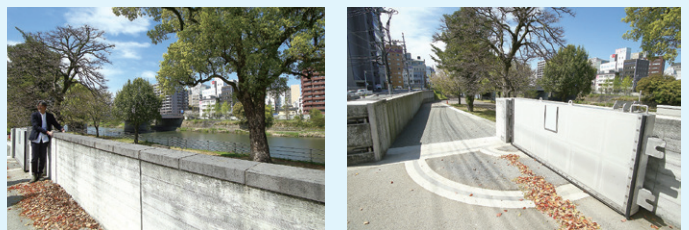
道路側から見た堤防。頂部には阿蘇産の溶岩石「鍋田石」があしらわれています 普段は開放されているゲート
