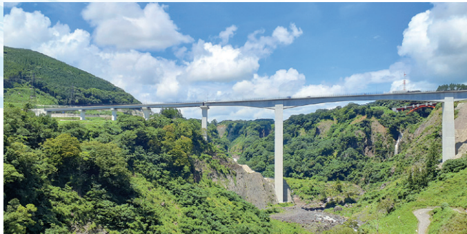
2021年に完成した新阿蘇大橋 国道57号に近い橋脚2本に「ノックオフ」が取り入れられています(松村教授提供)
