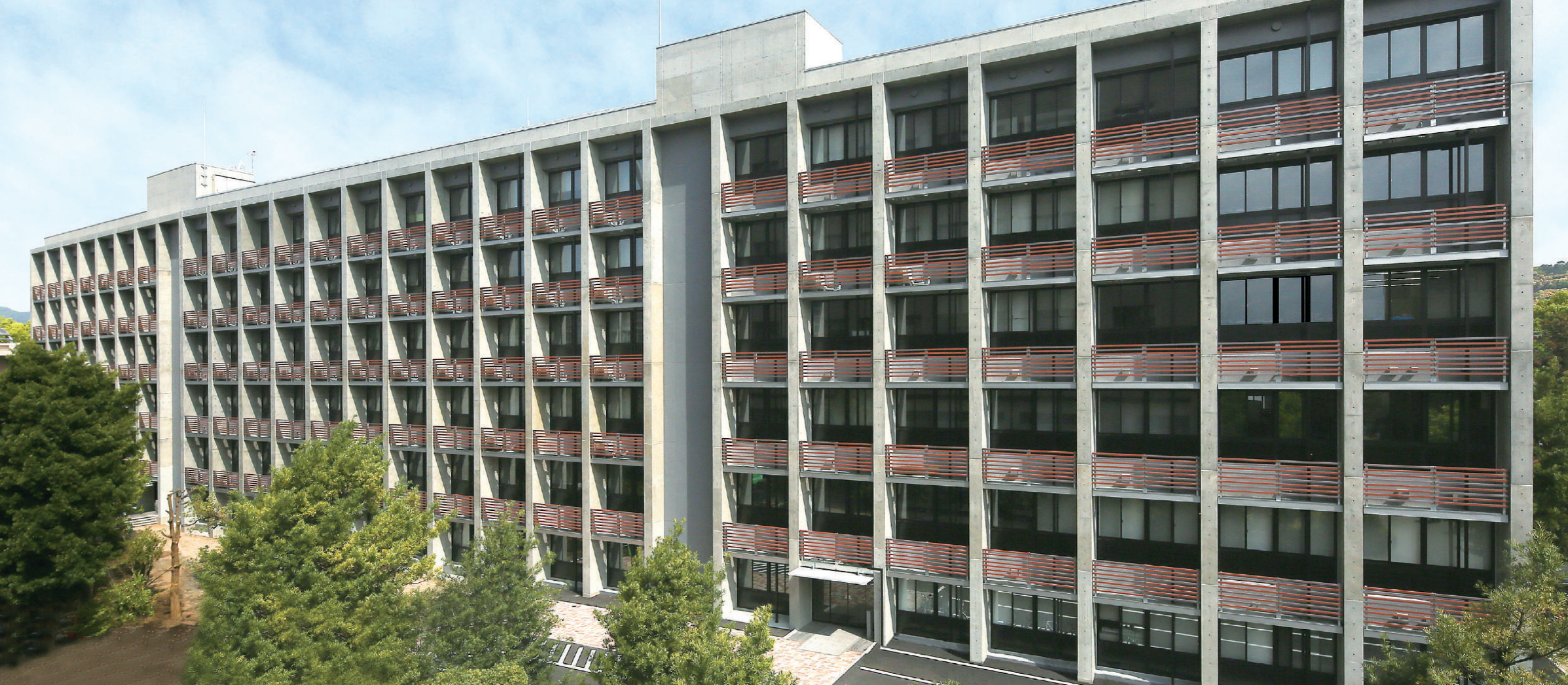
熊本大学復興シンボルのひとつ、熊本地震後に再建された工学部1号館(2019.4月竣工時の写真)
