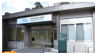
愛称 東京エレクトロン イノベーションプラザ 施設等名 ▶ イノベーションプラザ パートナー ▶ 東京エレクトロン九州株式会社
