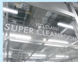
SOIL内のスーパークリーンルーム
