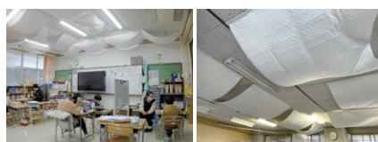
吸音材設置の様子
