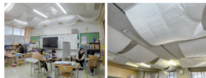
吸音材設置の様子
